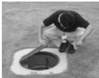
公園の浄化槽点検中
